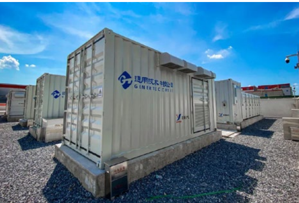
通用技术国际承担的江苏时代 12.5MW/52MWh 项目是国内用户侧规模最大液冷储能系统，获“2022 年度储能行业应用创新金藤奖”
