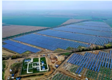
匈牙利 考波什堡 100MW 光伏电站项目
