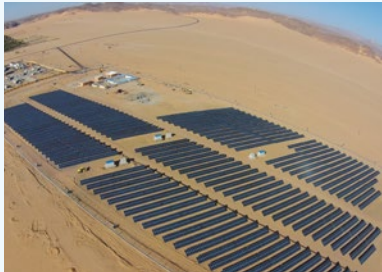
阿尔及利亚 25MW 光伏电站项目
